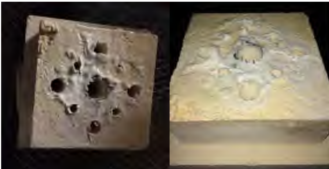
Abbildung 3.34: Ausgebauter Preheating-Brennerstein nach ca. 4 Wochen in Betrieb (Quelle: UAS)
