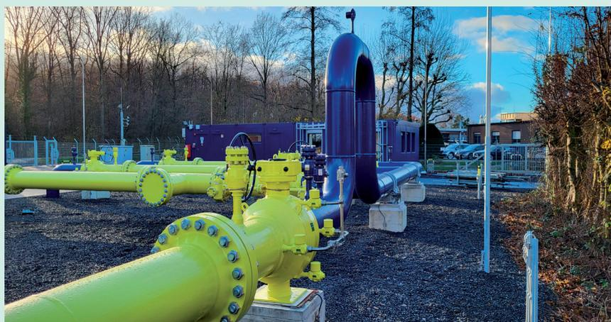
Um den Anforderungen an die Qualifikation gerecht zu werden, hat die Open Grid Europe (OGE) eine H2-Trainingsstrecke errichtet, die es ermöglicht, den Umgang mit Wasserstoff unter realen Bedingungen zu trainieren.
