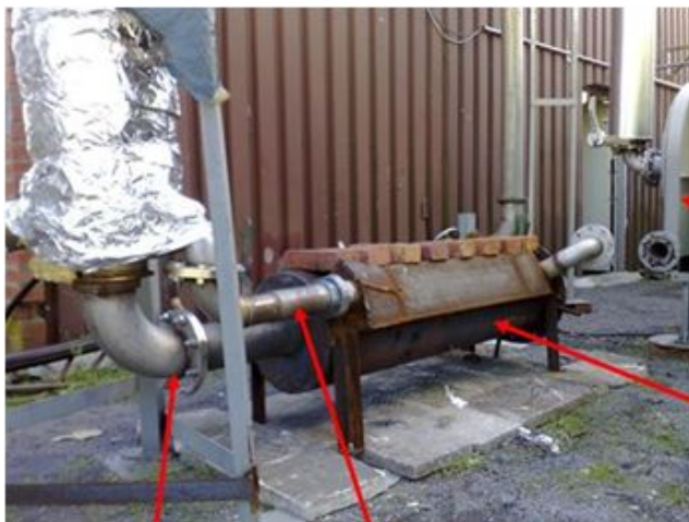
a) Aufbau des COSTAIR-Brenners
