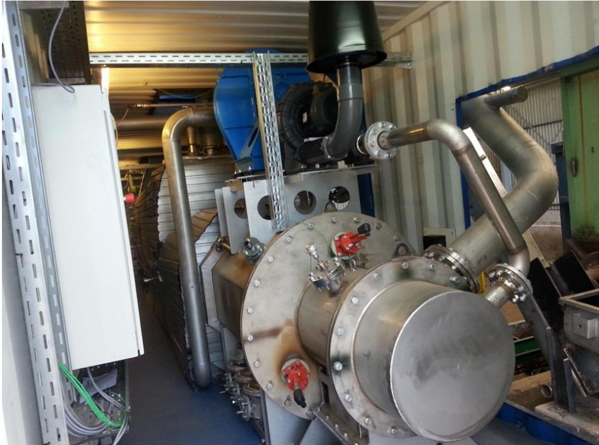
Abbildung 3-55: Einbau Brennersystem in Anlage
