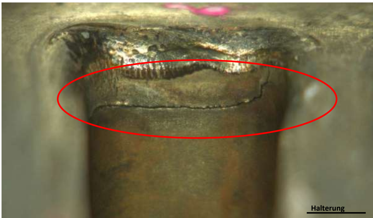
Abbildung 2-23: Korrodiertes und gerissener Winglet-Kanal, Rissbildung unter der Schweißnaht
