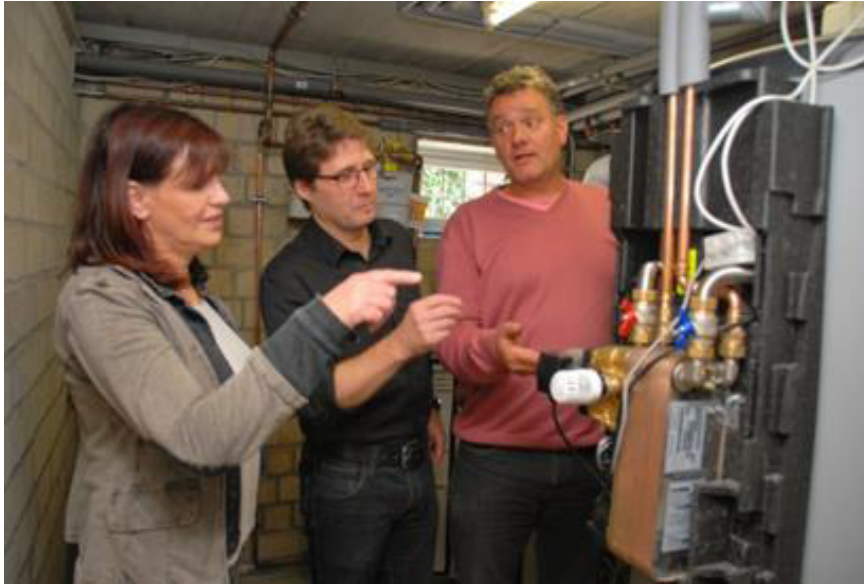
Abbildung 194: Der Fachinstallateur beschreibt das neu installierte KWK-System
