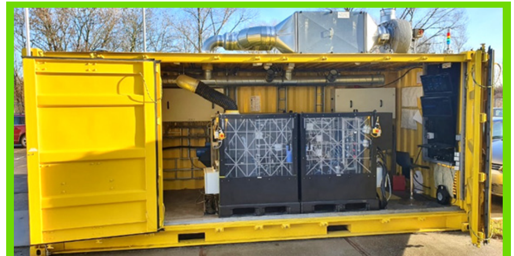
Das Elestor-Batteriesystem mit Modulen mit einem Gen4-Stack
