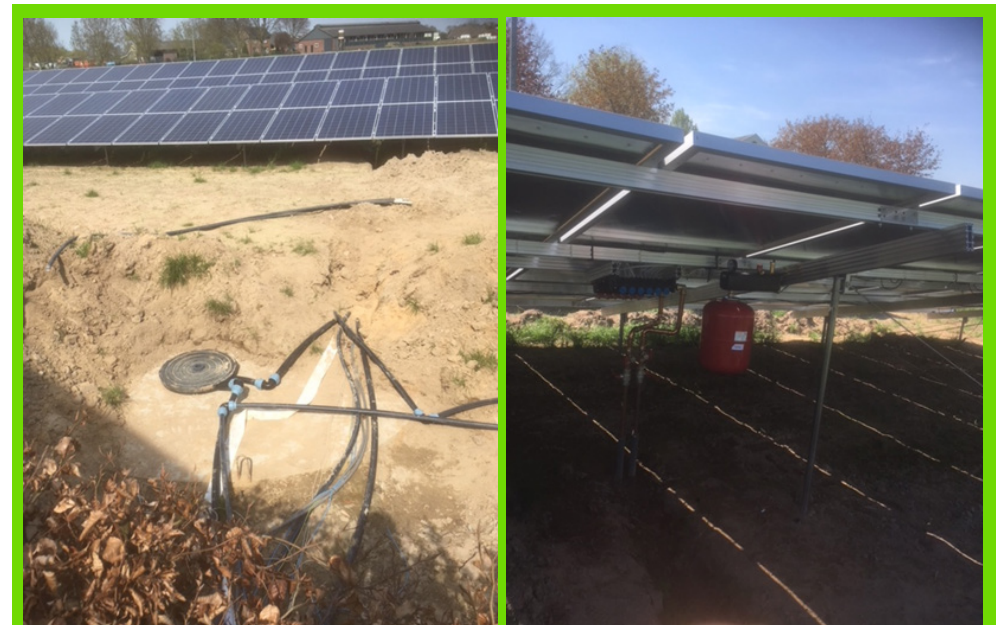
Die Bilder zeigen, wie die Komponenten im Untergrund und im Kniestock angebracht werden.
