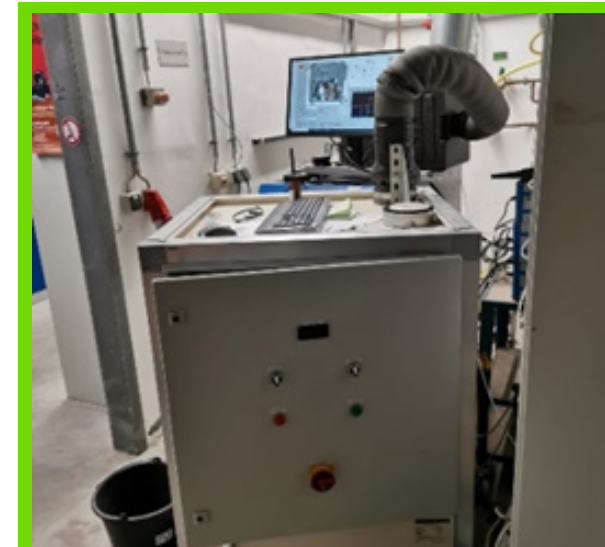
Prüfung des EnerTwin im Biogasbetrieb bei GWI (Essen)
