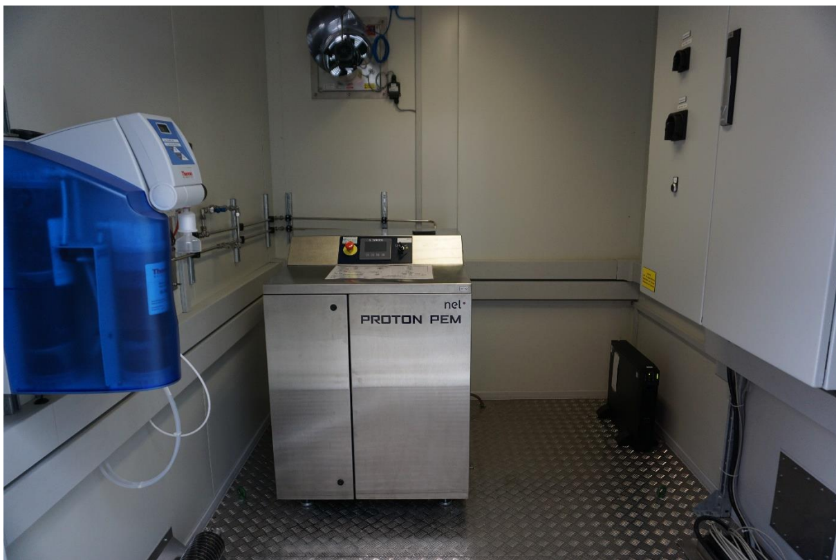
Abb. 3-6: Innenansicht des Elektrolyse-Containers im Projekt EnerPrax
