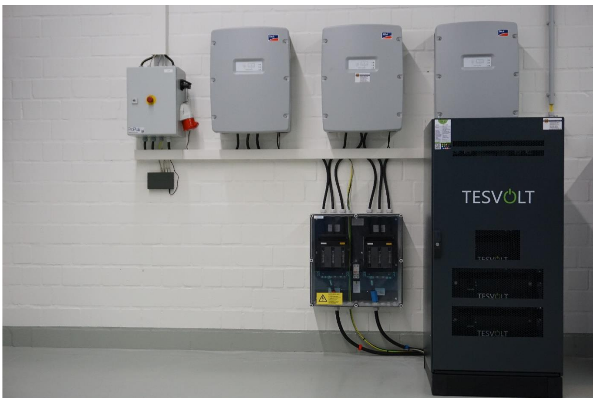
Abb. 3-3: Ansicht des TESVOLT TS25 Lithium-Ionen-Speichersystems im Bioenergiepark Saerbeck
