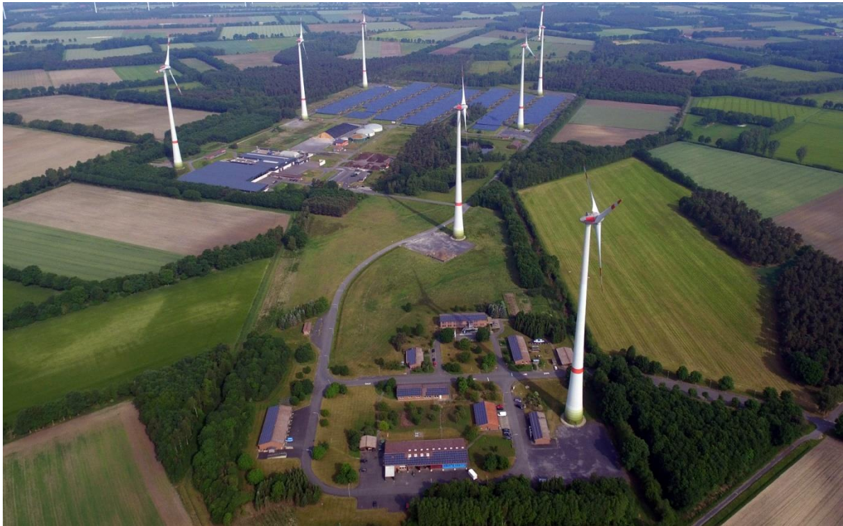
Abb. 2-1: Luftaufnahme vom Bioenergiepark Saerbeck. © Simon Nießen, FH Münster 2017
