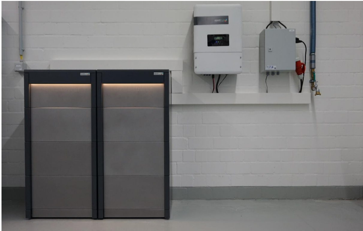
Abb. 3-4: Ansicht des CrystalTower 13.0/3 Lead-Crystal-Speichersystems im Bioenergiepark Saerbeck
