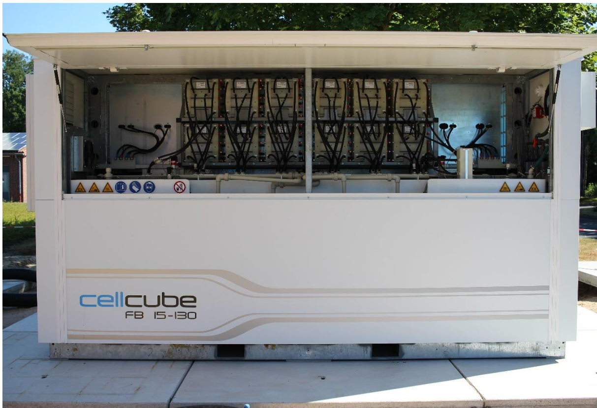
Abb. 3-5: Ansicht des Cellcube FB 15-130 Containers im Bioenergiepark Saerbeck
