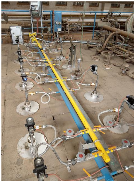
Abbildung 3.33: Detailsansicht der neuen Injektorbrennergruppe [IZF]
