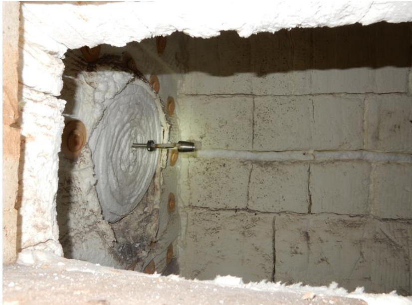
Abbildung 3.25: Blick durch das Sichtfenster auf den montierten Testbrenner [GWI]
