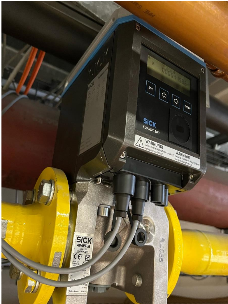
Abbildung 3-61: Ultraschallgaszähler am GWI (Foto GWI)
