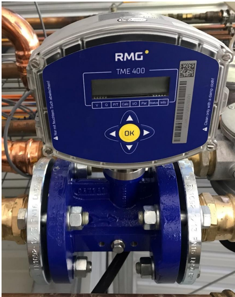
Abbildung 3-60: Turbinenradgaszähler am GWI (Foto GWI)
