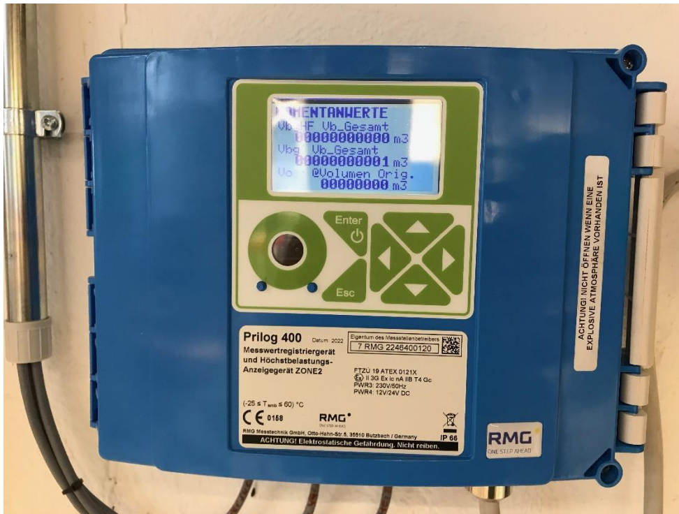
Abbildung 3-62: Datenlogger für die Einbindung der Gaszähler ins Netzwerk (Foto GWI)
