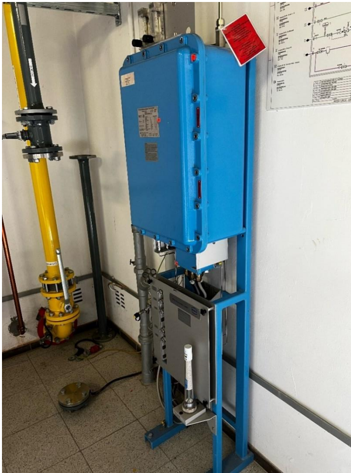
Abbildung 3-63: Gaschromatograph zur Bestimmung der Gaszusammensetzung (Foto GWI)
