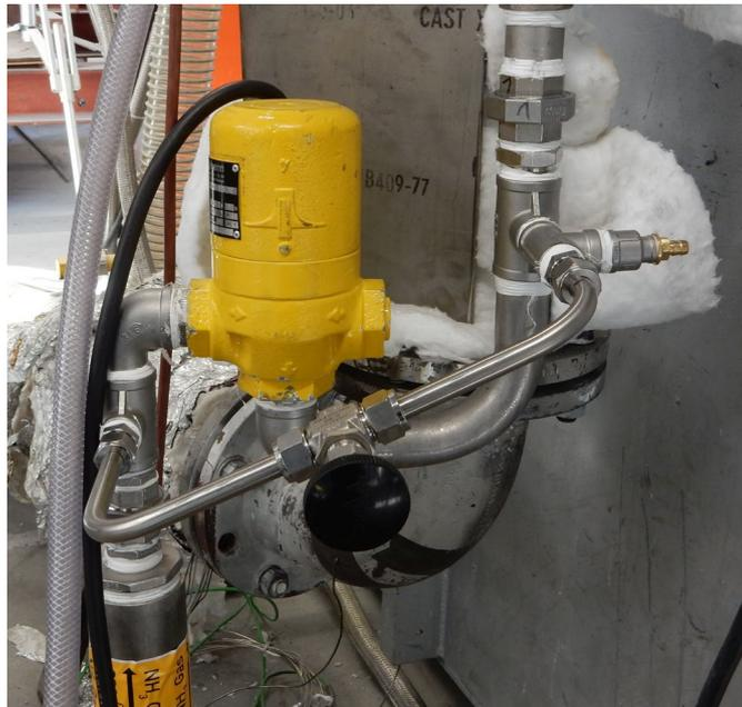
Abbildung 14: Verwendetes Gasmagnetventil (Quelle: GWI)
