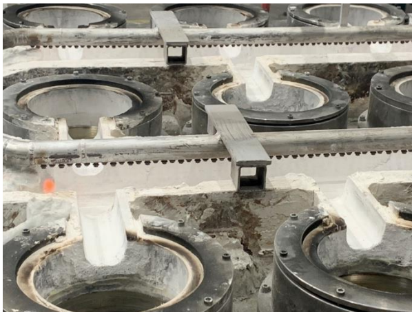
Abbildung 3-11: Vorwärmung des Gießverteilers mittels Gasbrenner (HMT)
