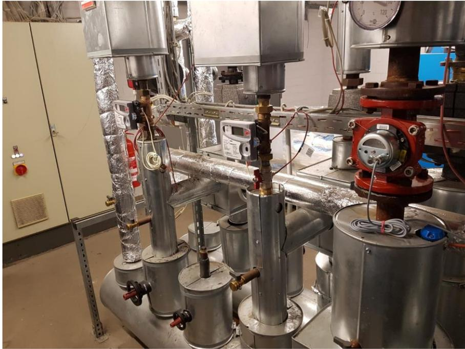
Abbildung 3: Installierte Wärmemengenzähler in verschiedenen Heizsträngen
