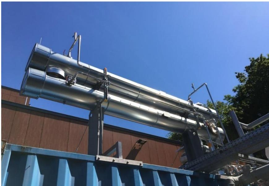
Abbildung 8: Neuinstallierter, zweistufiger Wärmeübertrager zur Nutzung der Abwärme des BHKW-Abgases
