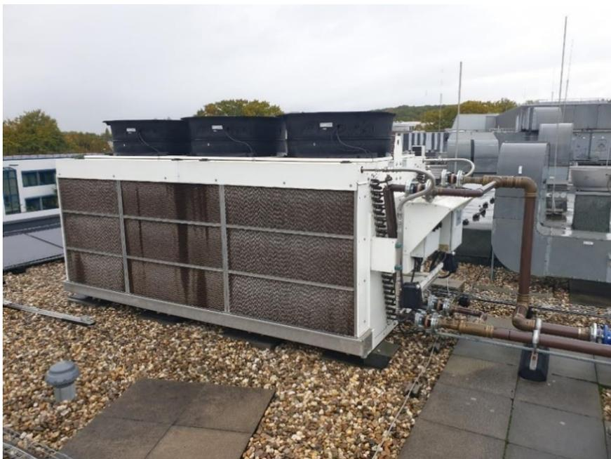
Abbildung 10: Hybrider Rückkühler auf dem Dach des TAZ-Gebäudes
