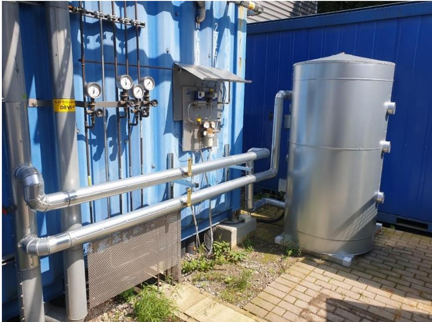
Abbildung 11: Installation des Wärmepufferspeichers
