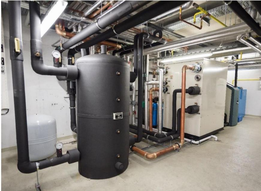
Abbildung 9: Fertige Installation der AKM und des Kältepufferspeichers
