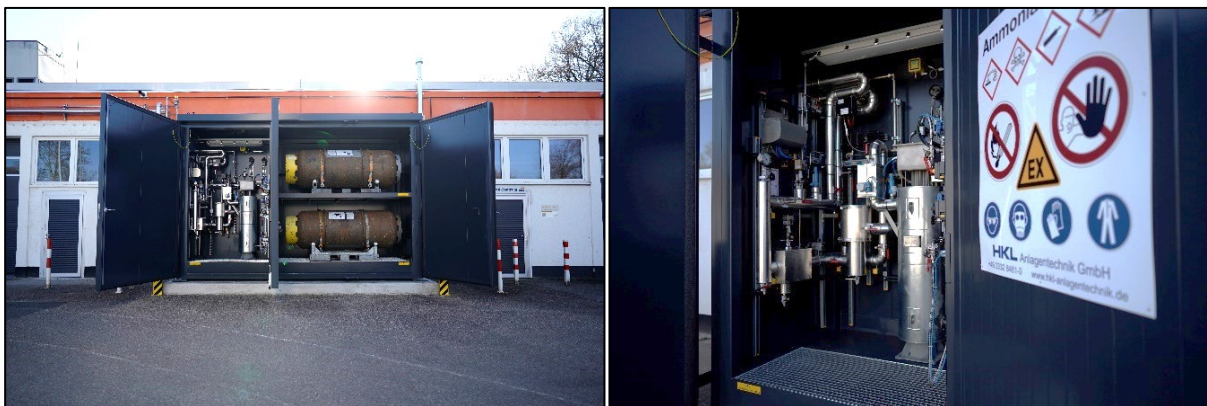
Abbildung 5.1: \text{NH}_3 -Verdampferanlage am GWI (Quelle: GWI)
