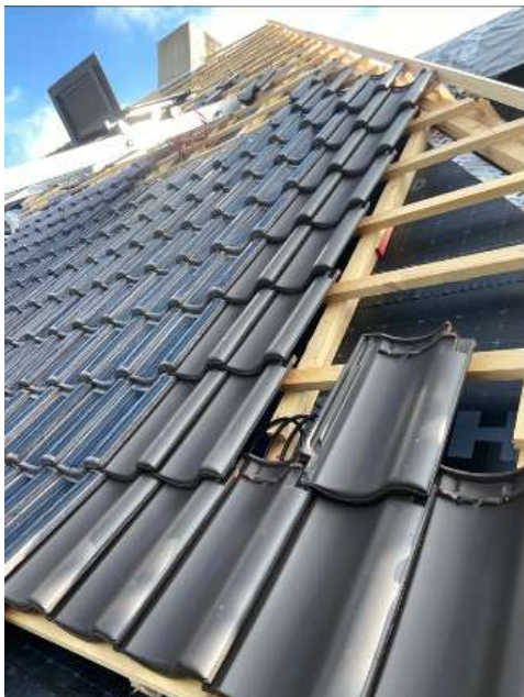
Abbildung 294: Originalziegel und SHDS – Richtung Straße
