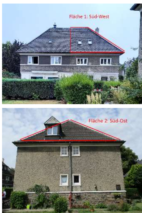
Abbildung 292: oben – Dachfläche Richtung Straße unten – Giebelseite
