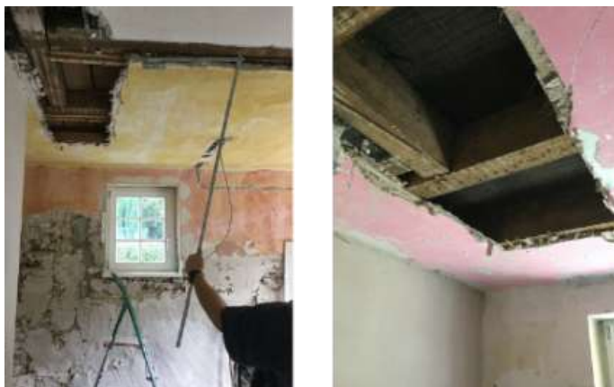
Abbildung 18: EG Luftschicht 200 mm – OG Luftschicht 500 mm
