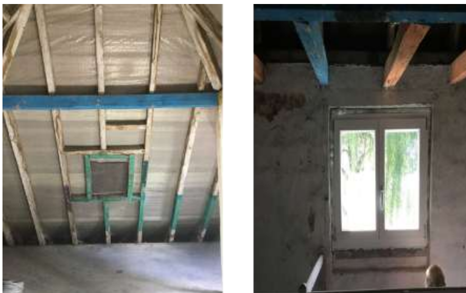
Abbildung 21: Dachaufbau mit Unterspannbahn (links) – Fenster DG (rechts)
