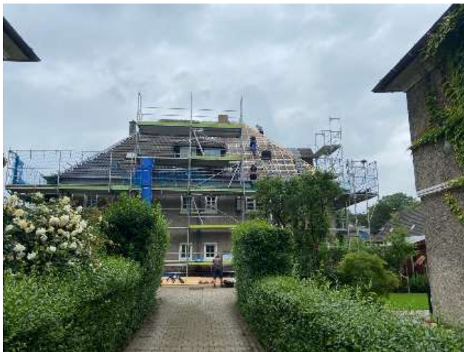
Abbildung 293: Aufgedecktes Dach – Daheim 3 B
