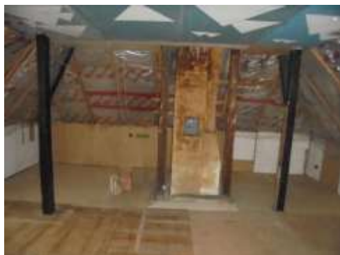
Abbildung 279: Boden in DG
