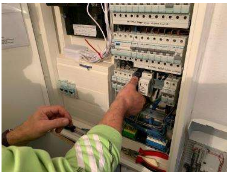
Abbildung 221: Montage des homee Energiemanagers auf der Hutschiene
