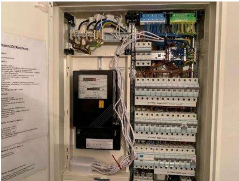
Abbildung 222: Montierte 3-Phasenzange
