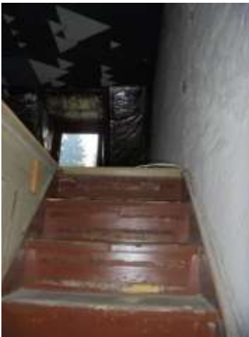
Abbildung 282: Aufgang zu Dachgeschoss
