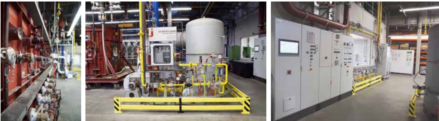
Abbildung 10: Modernisierung der IFT-Versuchshalle, (Quelle: GWI)
