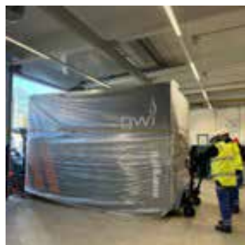
ABB. 30: LIEFERUNG DER REDOX-FLOW-BATTERIE
