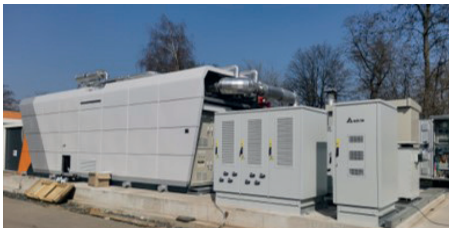
ABBILDUNG 7: AUFBAU DES HYBRID-SOFC-SYSTEMS AM GWI, QUELLE: GWI, 2022
