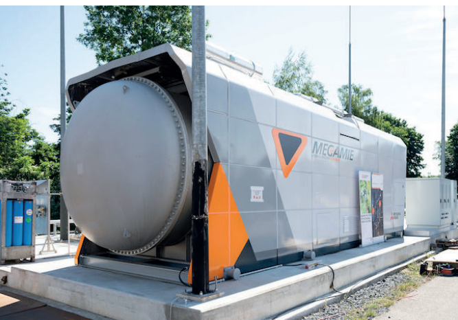
ABBILDUNG 7: AUFBAU DES HYBRID-SOFC-SYSTEMS AM GWI, QUELLE: GWI, 2022
