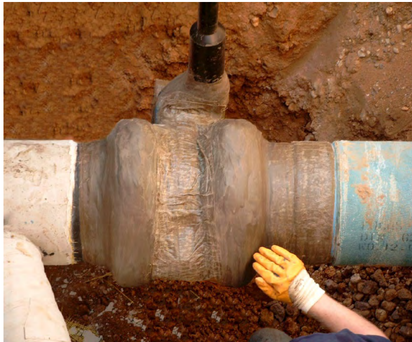
Umhüllung einer Armatur mit Petrolatumbinde
