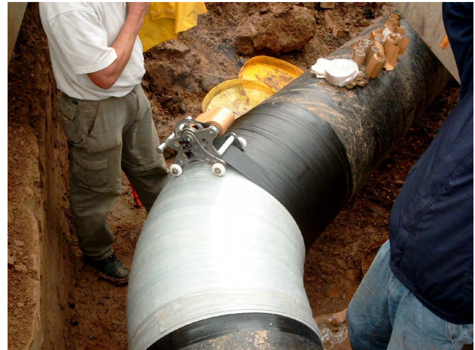
Rohrbogenumhüllung mit einem Kunststoff-Einschicht-System
