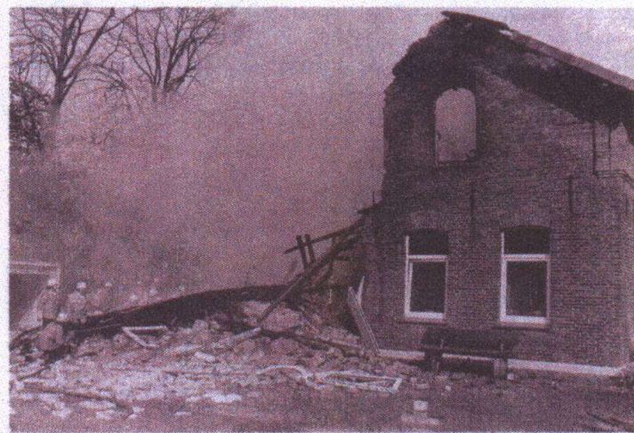
Explosionsunglück nach Baggerschaden
