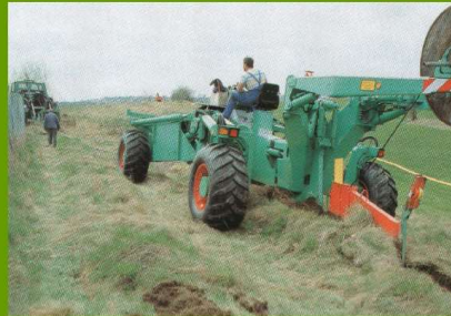
Verlegen von PE-Rohrleitungen und Kabeln mit dem Kabelpflug
