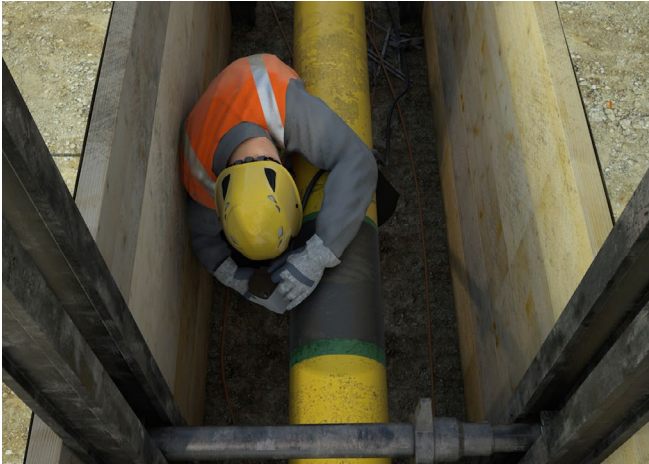
Abb. 13 Verwendung elektrischer Betriebsmittel in einer engen Baugrube
