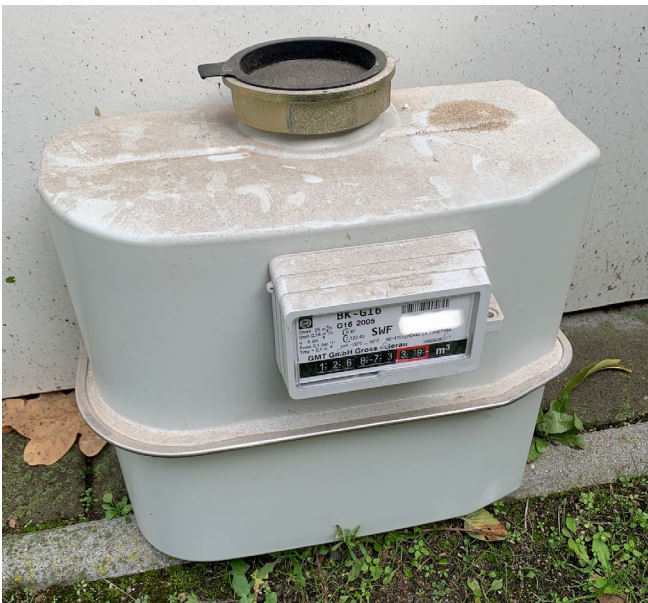
Abb. 42 Verschluss ausgebauter Gaszähler
