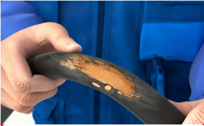
Abb. 12 Beschädigte elektrische Leitung
